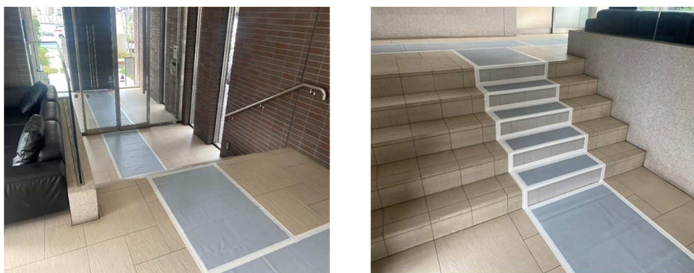
リユース可能な養生シート使用例
